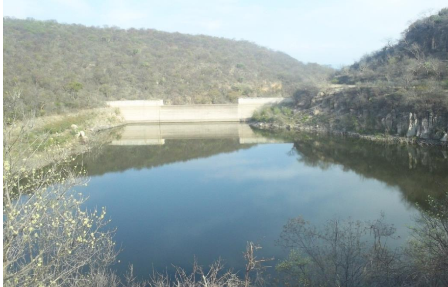
Vegetación y presa Santa Juana Jalpa Fuente: Captura Propia GCCROBER, 2014.
